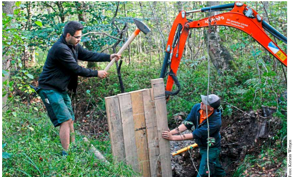
Abb. 2: Grabenverschluss unter Verwendung von Holzbohlen
