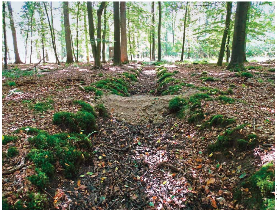
Abb. 1: Graben mit einfachem Lehmstau
