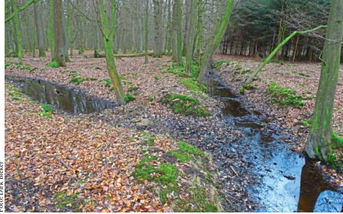
Abb. 3: Vergleich zwischen gestautem Graben (linke Bildhälfte) und ungestautem Graben mit Wasserabfluss
